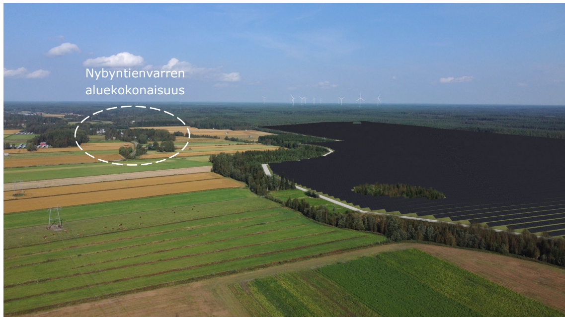
Kuva 31. Viistoilmakuvaan tehty havainnekuva paneelien sijoittumisesta alueelle. Havainnekuvas- sa on esitetty laskennallinen maksimimäärä paneeleita, mitä hankealueelle mahtuu. Kuvasta puuttuvat kuitenkin paneelien väleihin sijoittuvat huoltotiet. Kaavoitusprosessin aikana selvitetään paneelien lopullinen määrä ja toiminnan laajuus tarkemmin.
