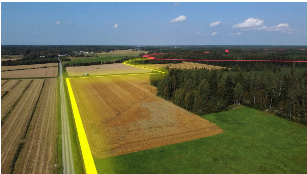
Kuva 37. Näkymä Brännskogintien varrelta lounaasta koilliseen. Maakaapeli rakennetaan tiealueelle, periaate näytetään keltaisella viivalla. Kaavoitusalue näytetään punaisella
