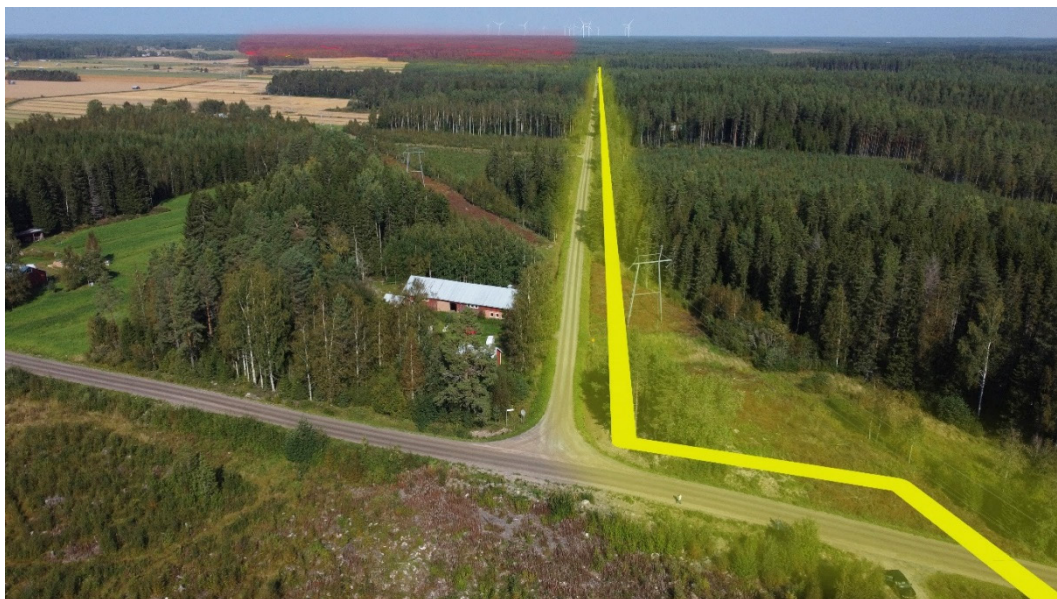
Bild 36. Vy längs Brännskogsvägen från sydväst mot nordost. Jordkabeln anläggs i vägområdet, principen visas med gult streck. Planeringsområdet läge visas med rött.
