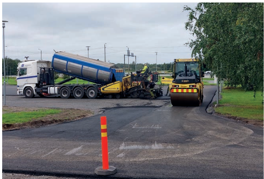
Parkeringen vid Malax-Korsnäs hälsovårdscentral har grundförbättrats och fått ny asfaltbeläggning i höst.
